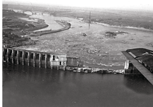
Руйнація греблі, яка відкрилася після пониження рівня верхнього б'єфу
