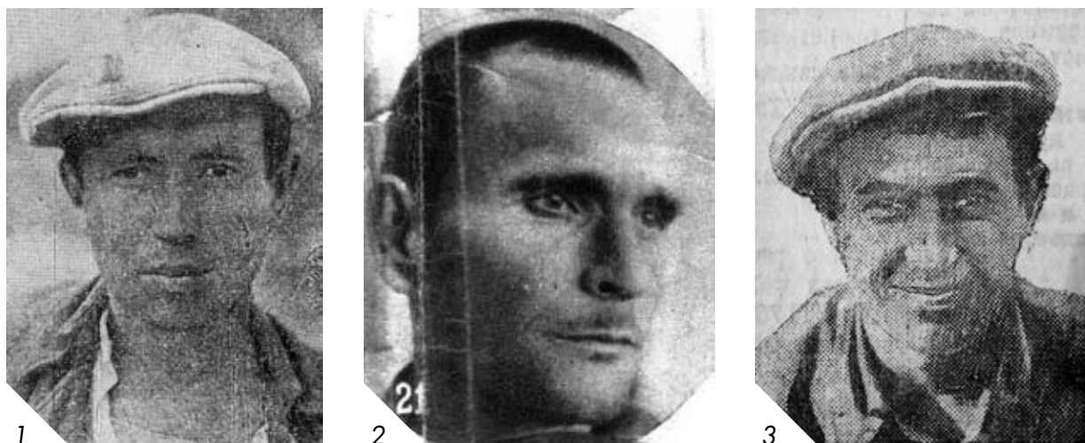
1. Бригадир-бетоняр З. Хайрулін. 1934 р. 2. Закір Тагеров – робітник-бетоняр, кращий ударник Дніпробуду. 1932 р. 3. Бригадир бетонярів Мансуров. 1935 р.
