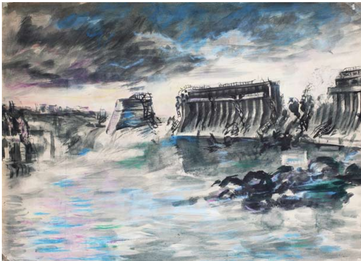
Разрушенный Днепрогэс. 1944 г. Акварель, бумага. 41 x 59. ЗКМ ЖС – 361 (1)
