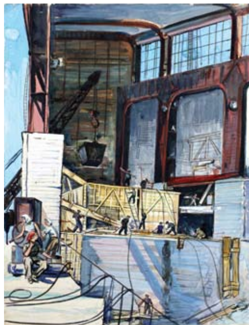
Бетонные работы на 4-м агрегате Днепрогэса. Акварель, бумага. 39 x 29,5. ЗКМ ЖС – 363
